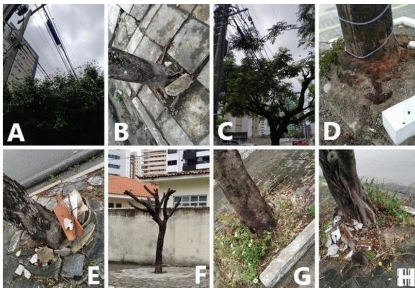
Figura 4. Problemas encontrados na arborização urbana na Av. Esperança em Manaíra, PB. A) contato com a fiação elétrica; B) calçada levantada; C) contato com a fiação elétrica; D) calçada levantada e danos a estrutura; E) danos a estrutura; F) espécie não identificada; G) danos a estrutura; H) calçada levantada. Fonte: autoria própria (2019).
